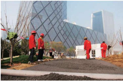
**二次摊铺** 透水混凝土为半流动性混凝土，通常厚度不低于12cm，一次型摊铺无法保证其密实度，所以通常采用基层和面层分层摊铺，在确保密实度的基础上还节约成本，一般基层采用较大的骨料以形成分级式透水结构。
