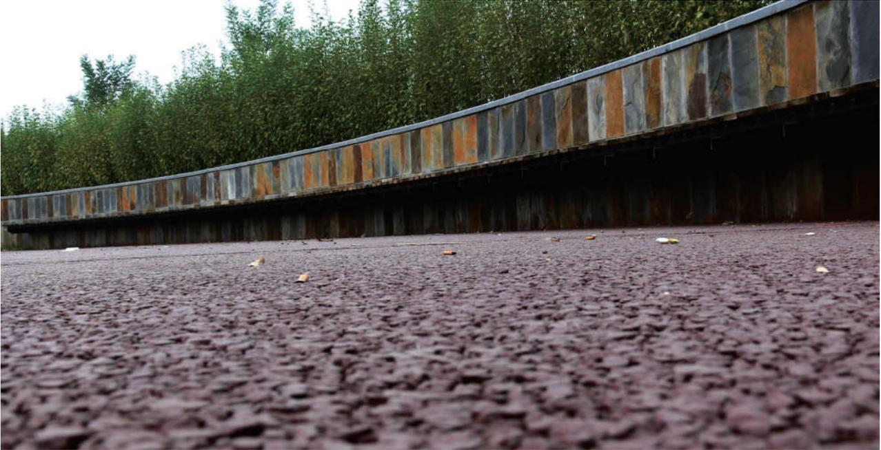
彩色透水混凝土又称生态透水混凝土、透水地坪，是由单位级骨料、水泥、专用胶结料（又称强固剂）、水、以及稳定剂等按照一定比例调配，经特定工艺搅拌而成的一种多孔轻质的专用半流动态混凝土，不含或少含砂，由骨料表面包覆一层经专用胶结料增强和改性了的水泥浆体相互黏结，专用机械现场摊铺而成的高透水率、高强度新型环保地面铺装材料。
