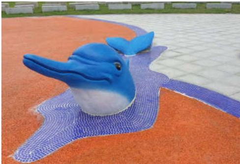
**色彩丰富** 彩色透水混凝土的颜色由内掺颜料所形成的通体彩色混凝土和面层喷涂双丙聚氨酯密封剂所构成，二者缺一不可，彩色密封剂起到矫正色差、润色加艳和增加耐磨性的作用，而内掺色料可确保即使磨损后也保持路面的基本色彩。
