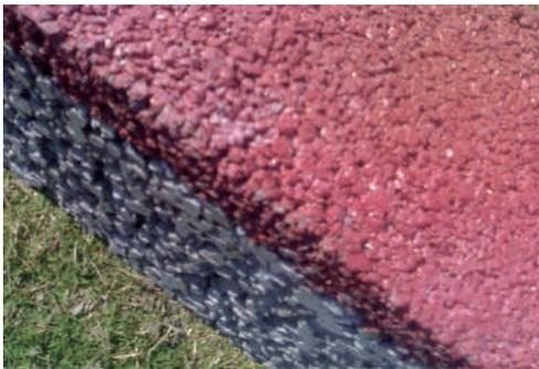
**结构类型** 彩色强固透水混凝土分为“上下通透型”和“渗透排水型”两种，对于透水性较好砂性土地区可采用上下通透型，而在淤泥质或粘土质土壤条件下应采用渗透排水型，即上层透水，而下层不透水，以免破坏路面基层结构。
